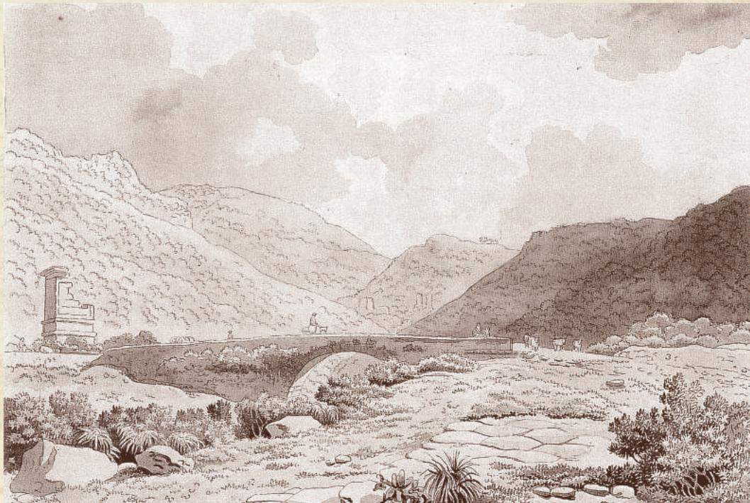
più di 9 m di luce ed è largo 12,5 m. Sui muri di parapetto del ponte sono stati collocate le guide lapidee del ponte romano, trovate durante i restauri del ponte rinascimentale. Poco prima del ponte sono i resti dell'Epitaffio, po-
